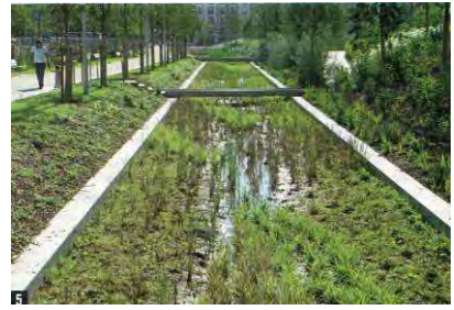
Noues et phytoépuration
