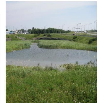
Figure 96 : Bassin de rétention, Source : CAGEQ
