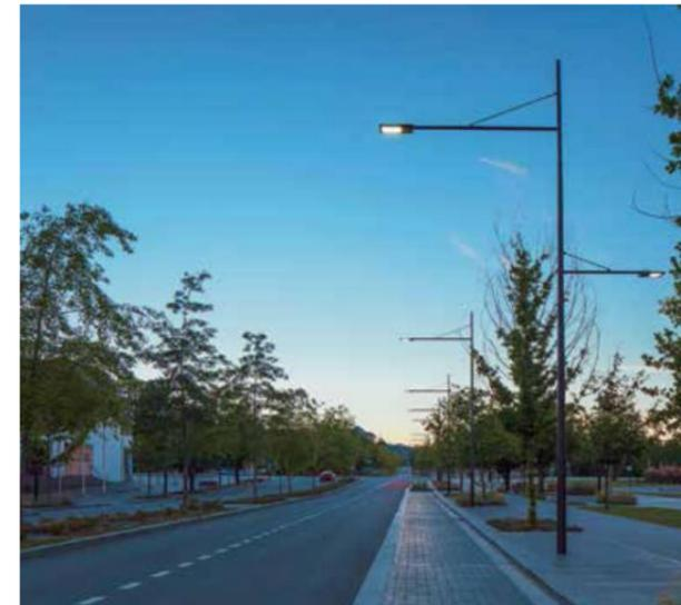
Figure 85 : Exemple de candélabre double-crosse, Source : we-ef
