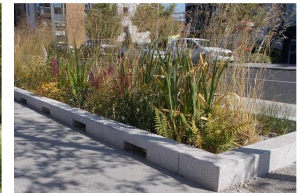
Figure 98 : Exemple d'un jardin de pluie proche d'une route à Salford (UK), Source : CCO
