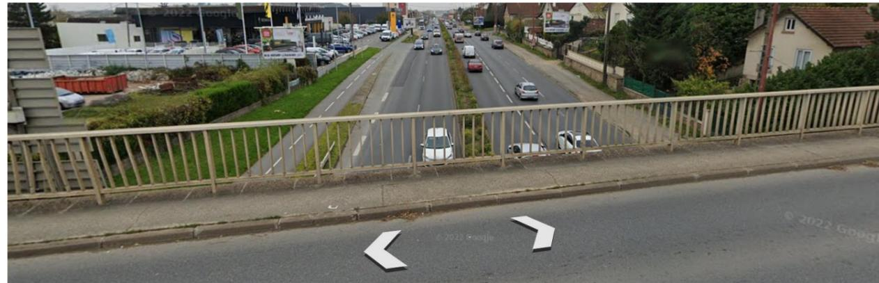
Figure 88: garde-corps en rive de l'ouvrage
